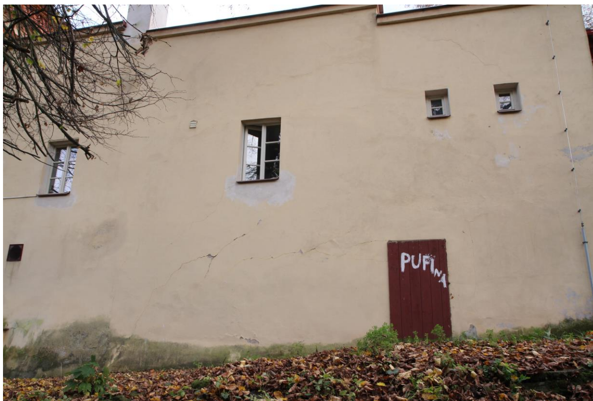
Současný stav omítek spodní části severní fasády (novodobá přístavba)
