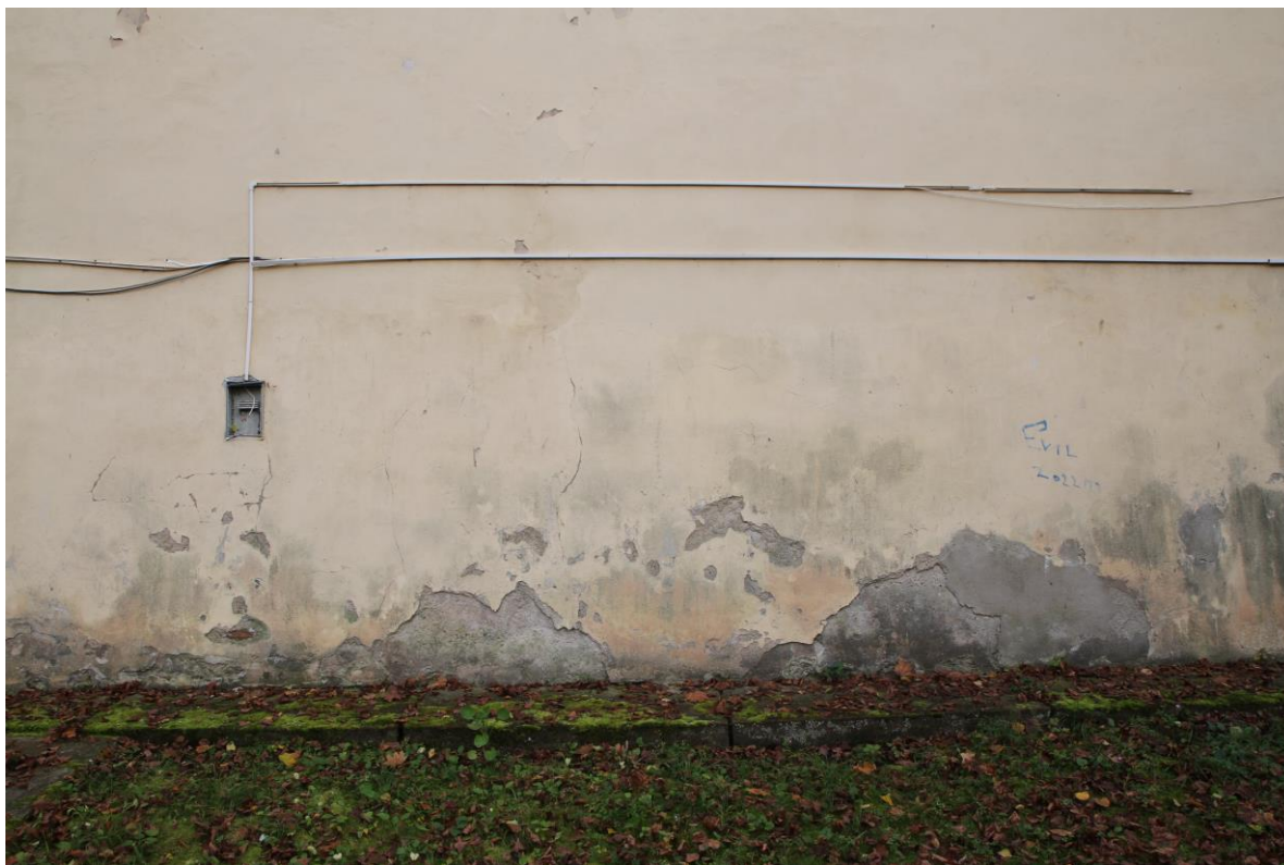
Současný stav omítek spodní části severní fasády (původní část objektu)
